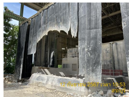
รูปที่ 10 ระบบกำจัดฝุ่นแบบ Dust Filter ในโรงโม่หินและระบบสเปรย์น้ำ
